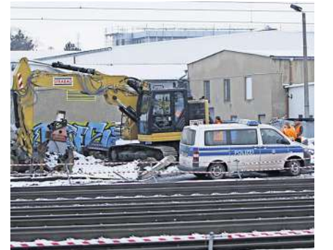
Bei Baggerarbeiten wurde die Fliegerbombe entdeckt. Foto: Dirk Neufe
